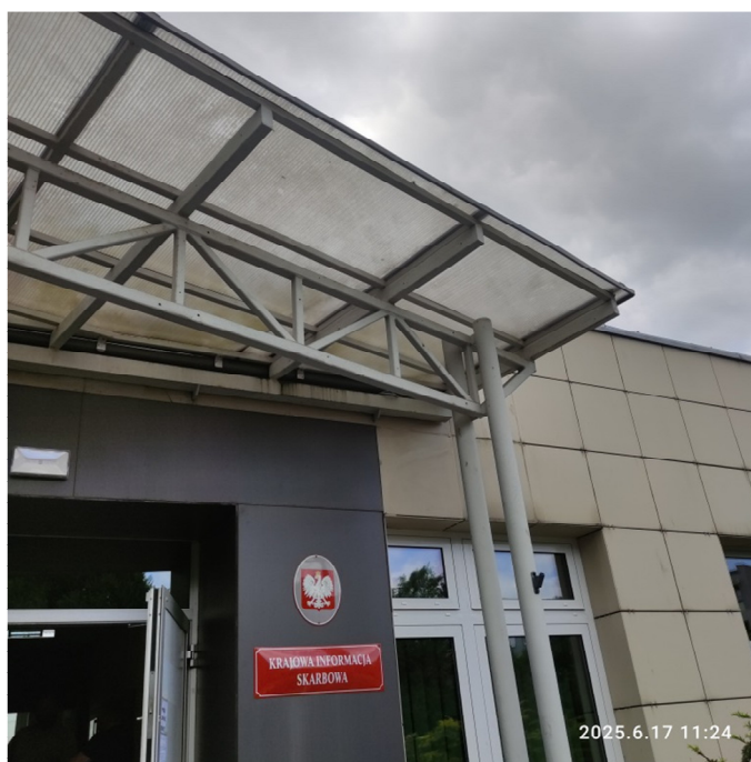
Fot. 2. Konstrukcja nośna dachu – słupy stalowe, stalowa belka przy ścianie zewnętrznej, drugi segment kratownicy
