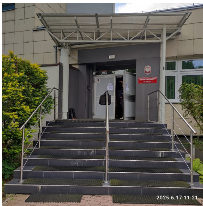
Fot. 1. Konstrukcja nośna dachu przy wejściu głównym budynku Krajowej Informacji Skarbowej
