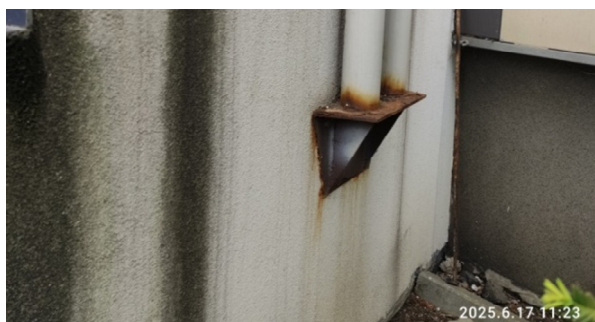
Fot. 5. Konstrukcja wsporcza słupów stalowych
