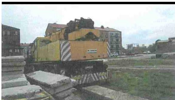
Fot. 73 —żuraw GROVE nr rej. PZ2398Y
